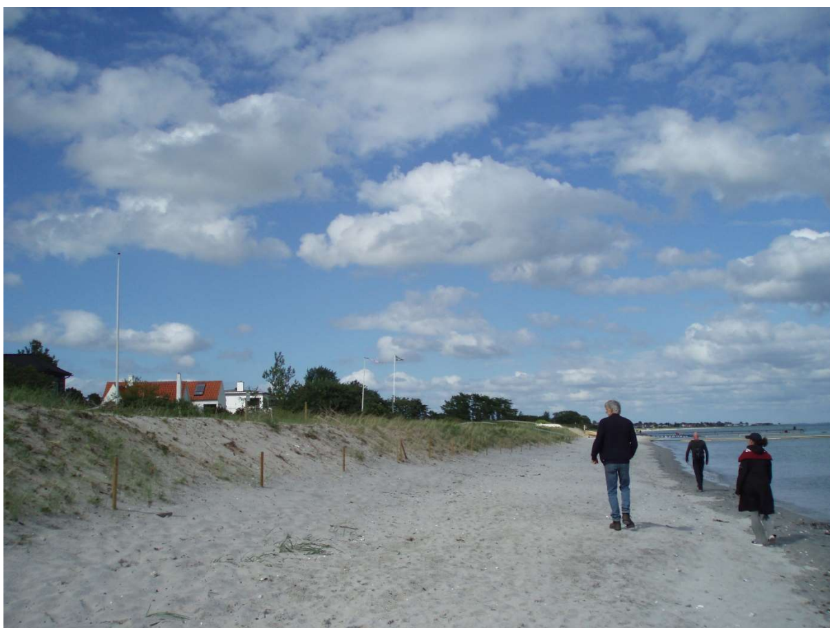
(10) Ahornvej set mod Birkevej. Der er pæn høj strand og deraf følgende god strandbredde. Nyanlæg af dige.
