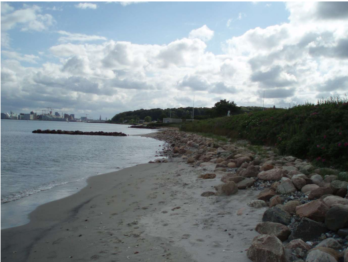
(8) Stor og dyb erosion betinget af rør og stenkastning ved Rønnevej, nordøstlige del.
