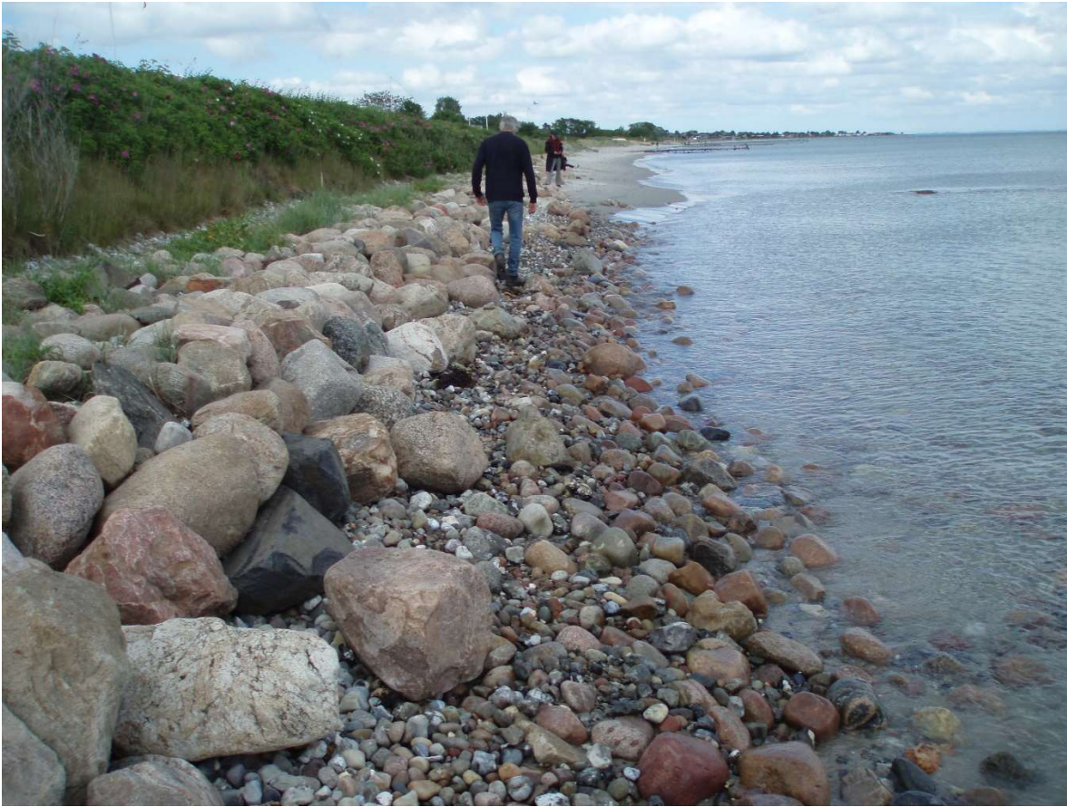
(7) Dårlig passage forbi skræntfodsbeskyttelsen med sten pga. erosionen ved Rønnevej.
