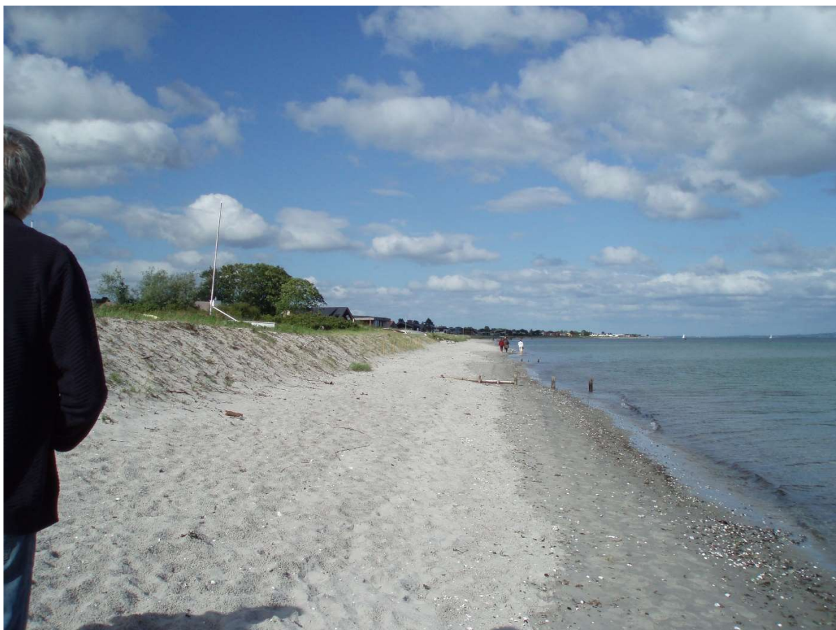
(12) Ikke så høj og noget smallere strandbred udfør Themsvej-L.P. Bechsvej. Nyanlagt dige er noget fremskudt.
