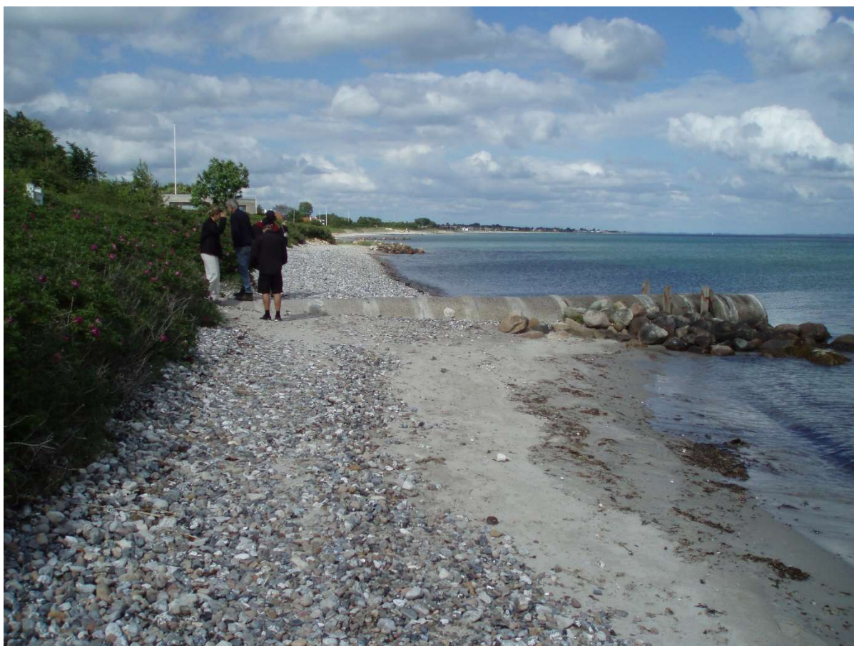
(4) Der kan let komme erosion påny syd-vest for rørdløbet LU 23g.
