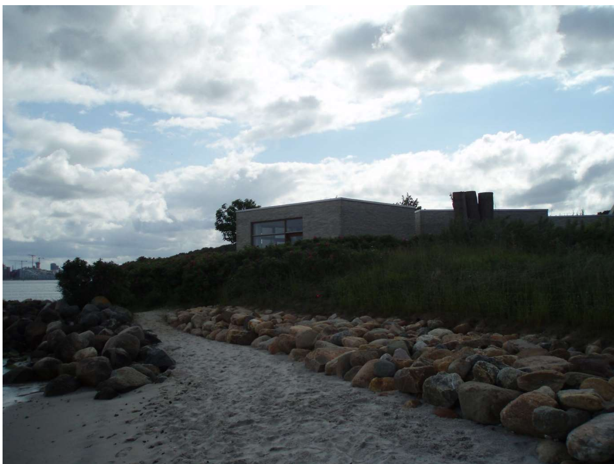
(6) Passage ved Platanvej med stenbeskyttelse. Det fungerer godt trods de snævre forhold.
