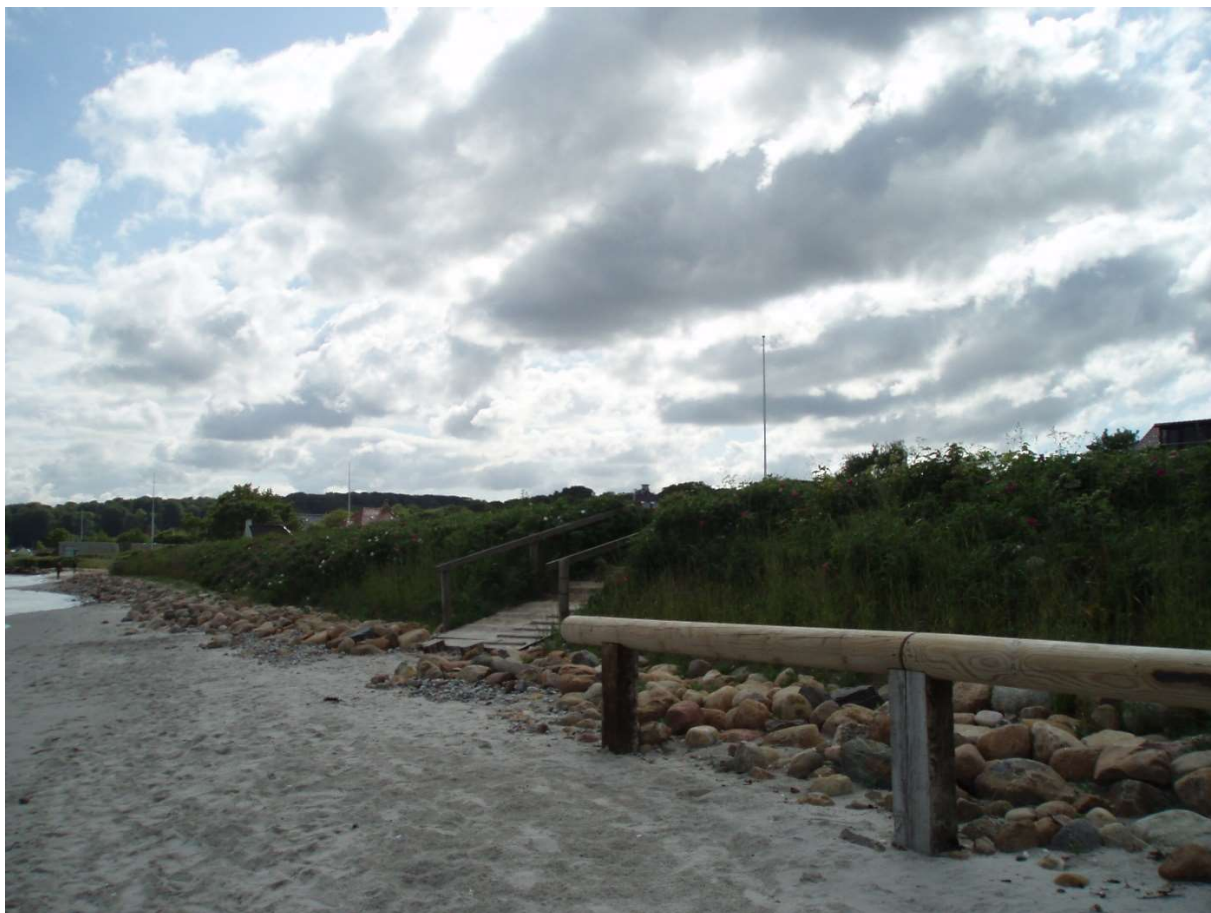
(9) Lindevangsvej med skræntfodsbeskyttelse med sten.
