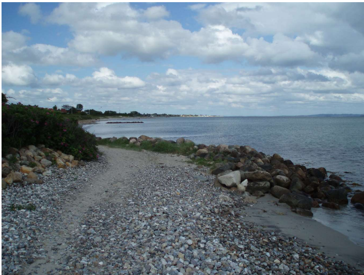
(5) Passagen med stenbeskyttelse ved "pynten" ved Platanvej.
