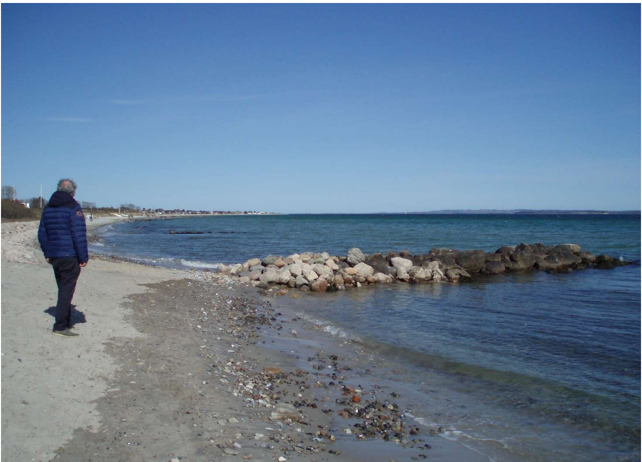
(2) Rønnevej: Der ser ud til også at være lagt nogle supplerende nye sten på stenkastningen inderst
