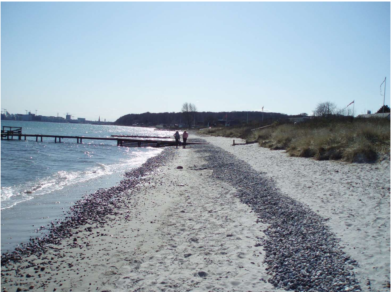
(8) Ahornvej strand set fra øst. Uden tilladelse forlænget bro med lodrette brædder, hofdeeffekt!
