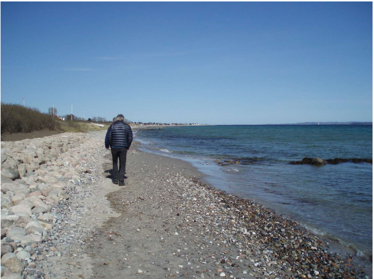
(4) Overgangen til Lindevangsvej vestlige del. Pænt med sand, nyanlagt digebeskyttelse
