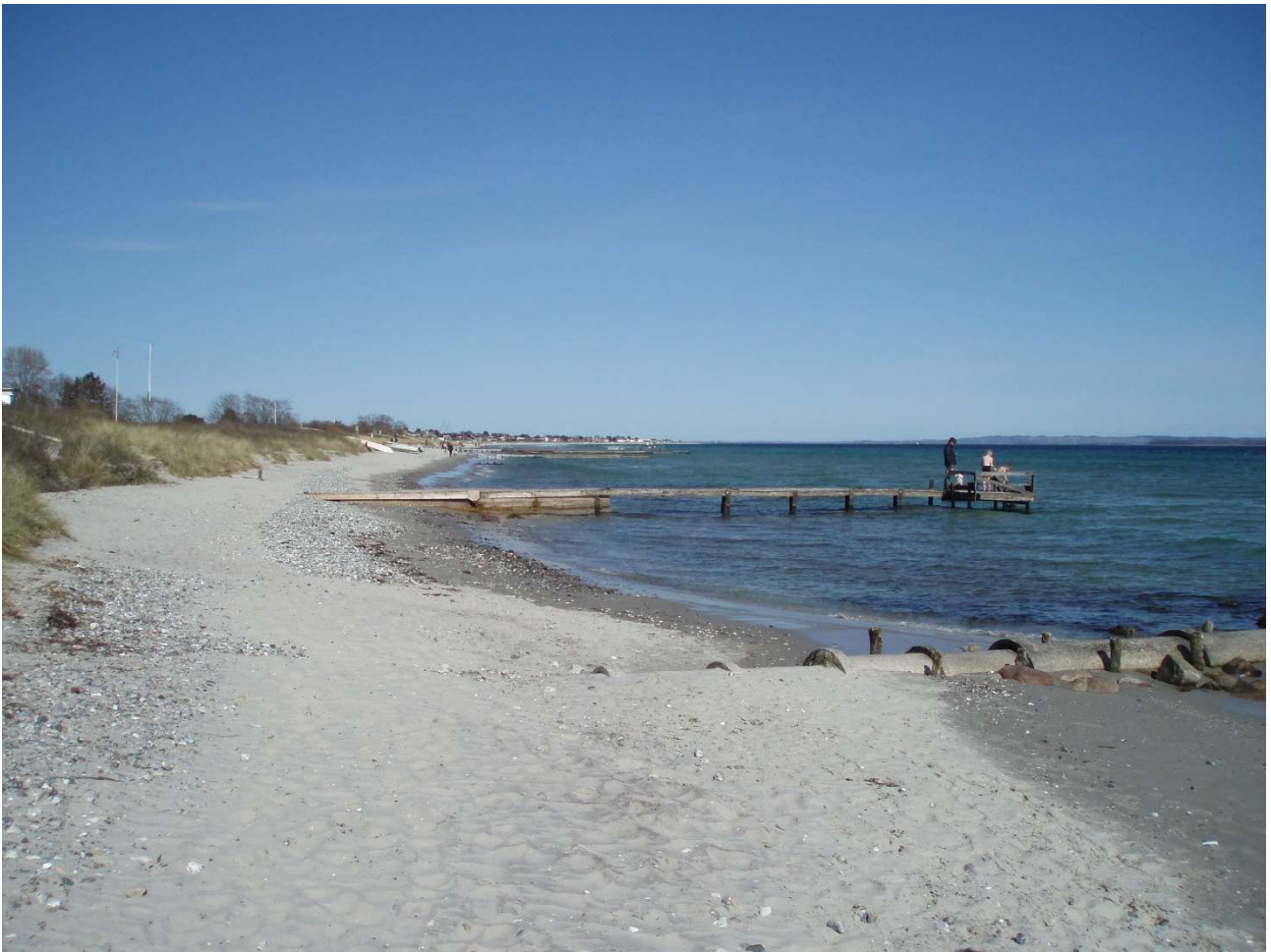
(7) Pænt med sand allerede fra før røret ved Ahornvej. Rørudløbet giver nogen erosion mod øst.
