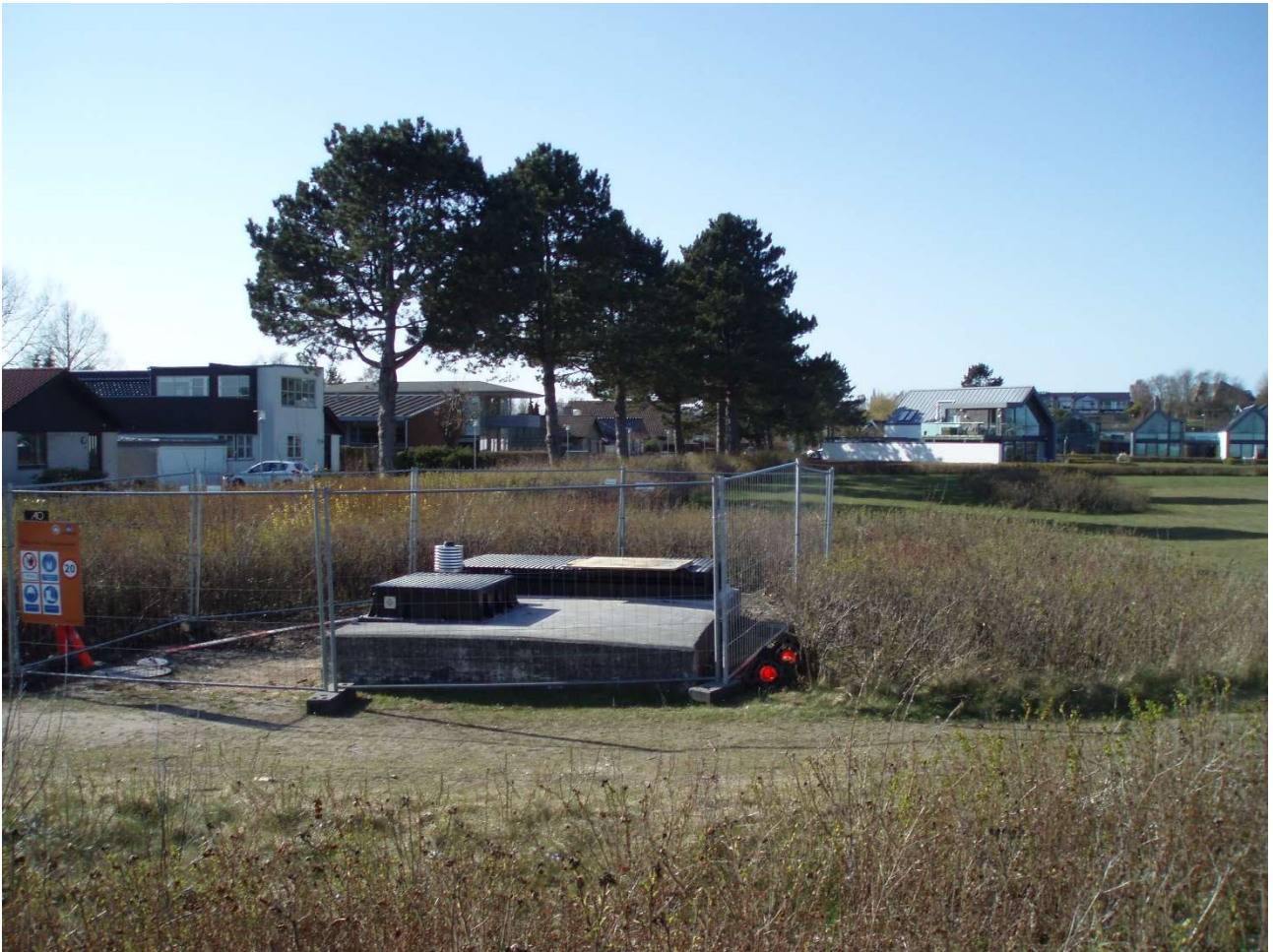
(11) Århus Vand har alle steder forhøjet ”karmene” på pumpestationerne med ca. 30 cm.
